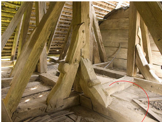
Tăpile și structura inferioară a turnului-clopotniță (foto. Alexandru Baboș)
